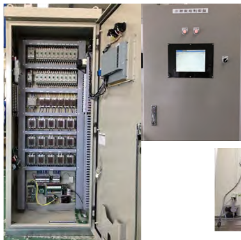
計測制御動力制御盤
