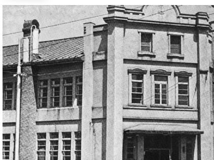
旧網走商工会議所会館 (昭和25年8月竣工)
