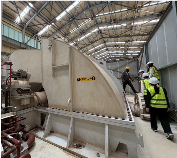
写真 3 オルカリア IV 地熱発電所訪問にて実際に使用されていた東芝のタービン
